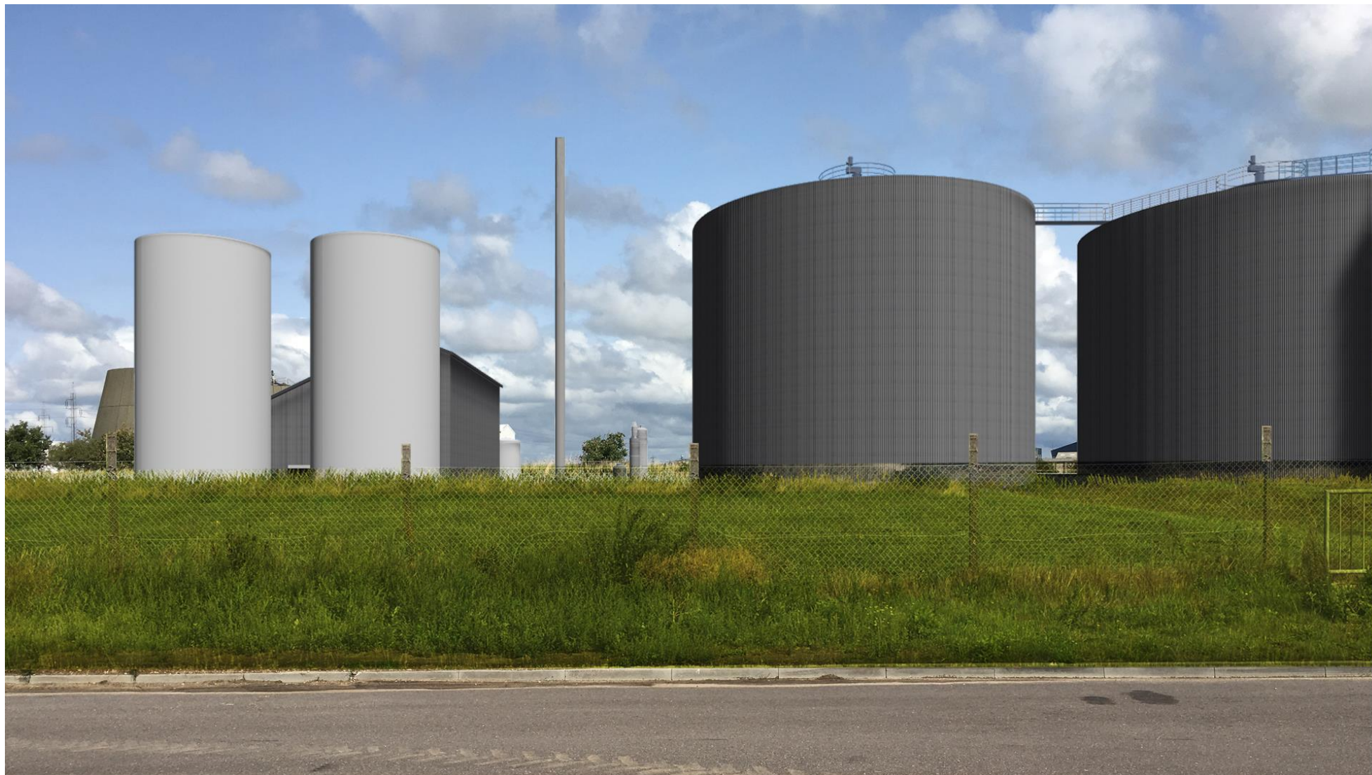
Figur 5: Fotostandpunkt 2 - Efter etablering
