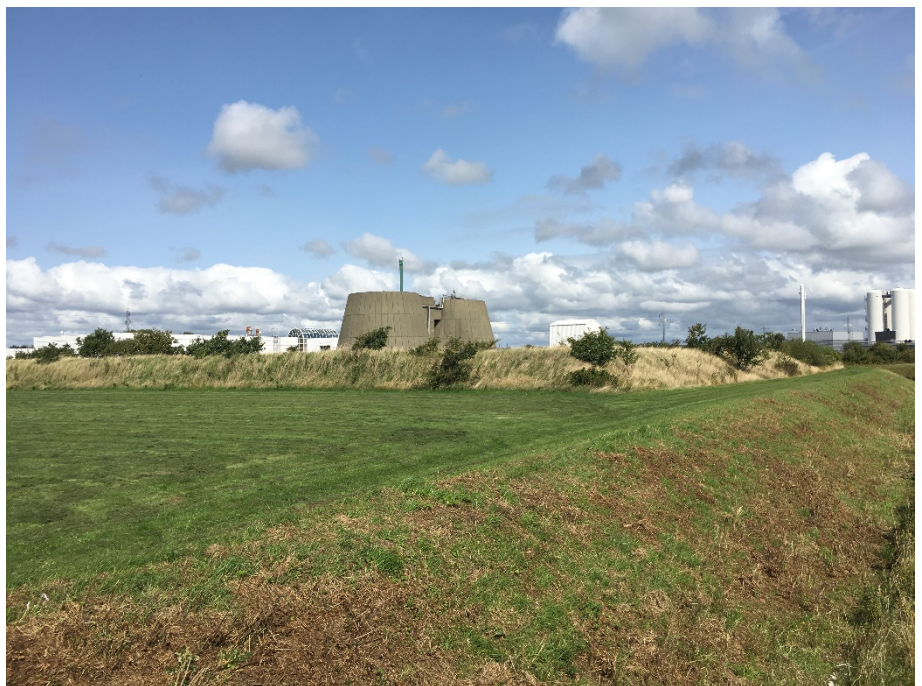
Figur 3: Fotoet er taget fra Mådevej mod Rensningsanlæg Øst, fra vest mod øst.
