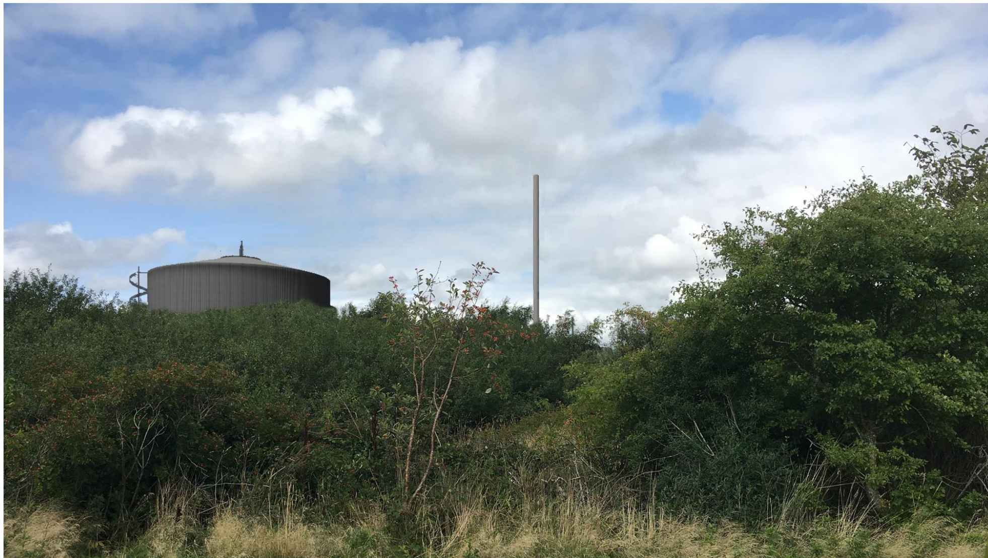
Figur 7: Fotostandpunkt 3 - Efter etablering
